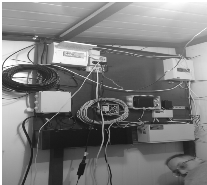
Рис. 5. Монтаж оборудования сеймостанции «Полтавка»
