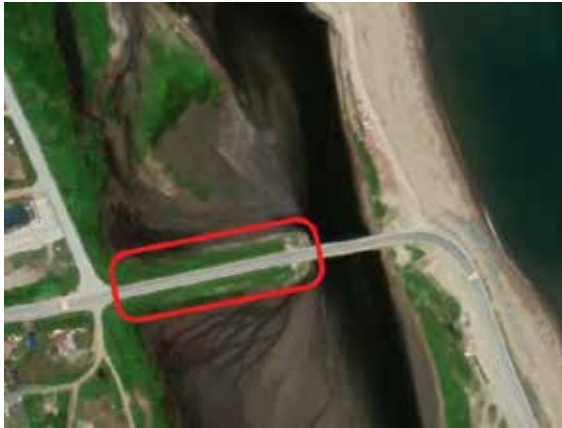
Рис. 2. Мост через пролив Красноармейский, красным выделена дамба
