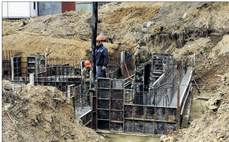
Вид стройплощадки НЗМУ, на который заливают фундамент, с вырубленным лесом, снятой почвой и выровненной территорией, апрель 2020 года
